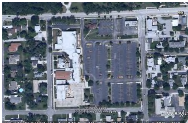
Bild vor dem Umbau
